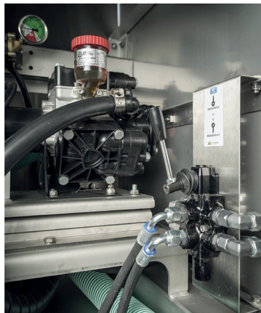
Omkopplingsventil mellan högtrycks- och saltlösningpump.
